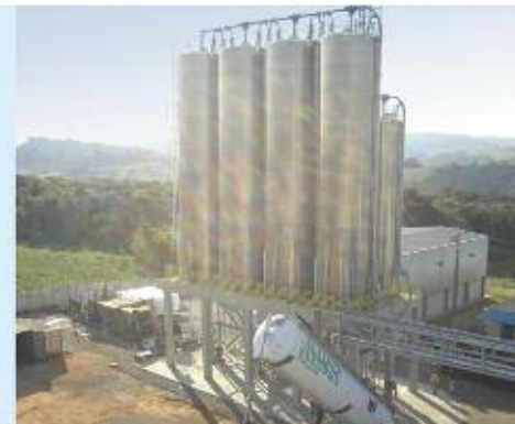
Site de production de compound, Brésil
